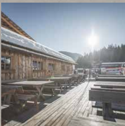
HENNSTOLL RIFUGIO POLLAIO
